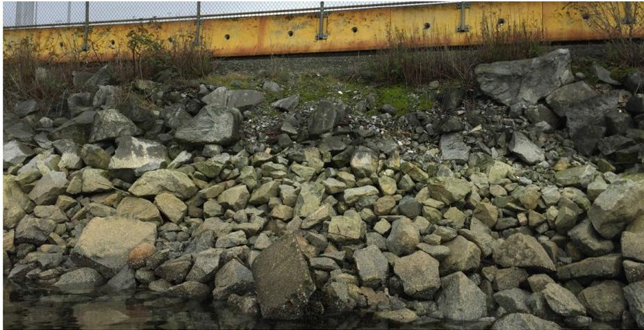
*Figure 3.1 : Dommages mineurs à la crête supérieure d'une pente d'armure de roche*
