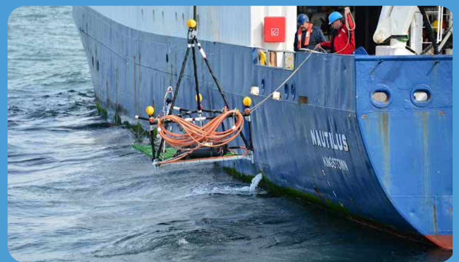
Installation d'une station d'écoute sous-marine au fond de l'océan
